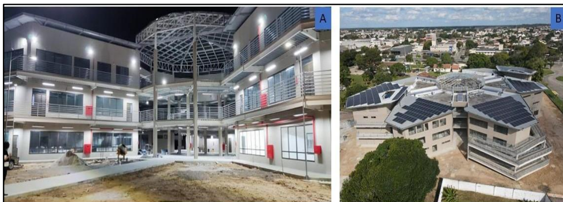
Figura 3. Complexo 2 do Campus Paulo Freire. (A) Núcleo Pedagógico em fase de finalização da construção (B) Imagem aérea do núcleo pedagógico.
