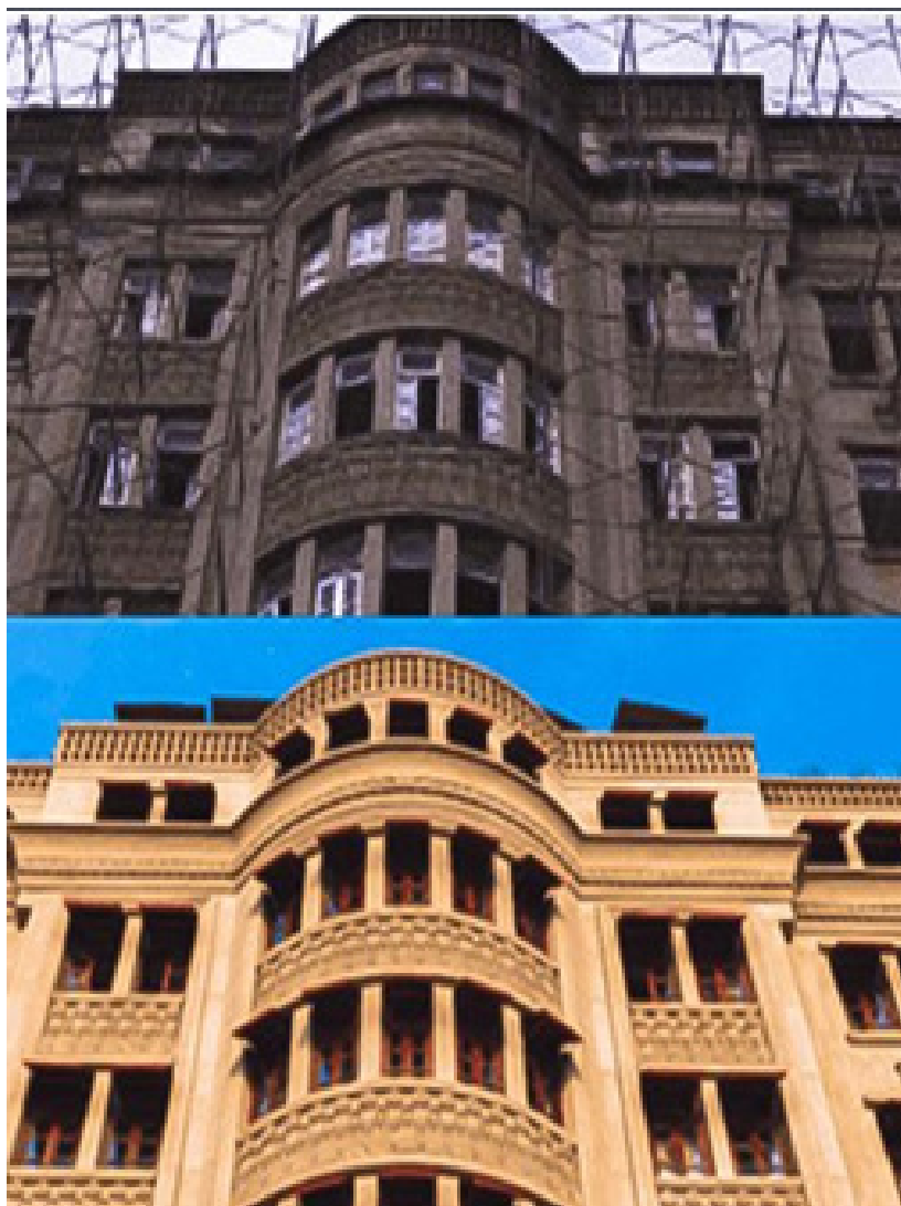
FIGURA 3: Retrofit em uma obra antiga
