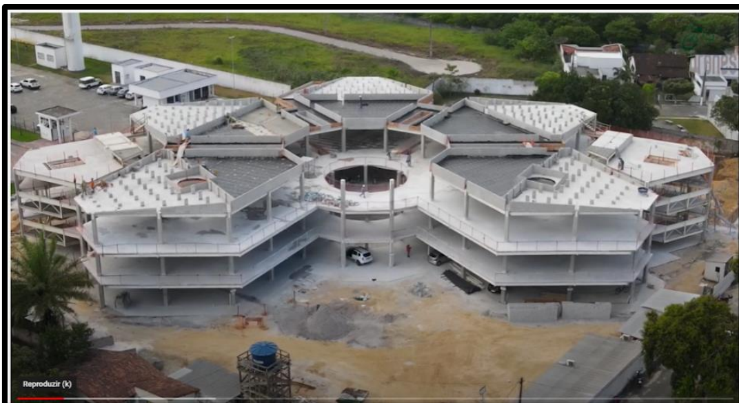
Figura 6 - Obra de Construção do prédio do Núcleo Pedagógico do Campus Paulo Freire na área do Complexo 2
